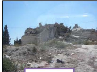
破壊された建物
